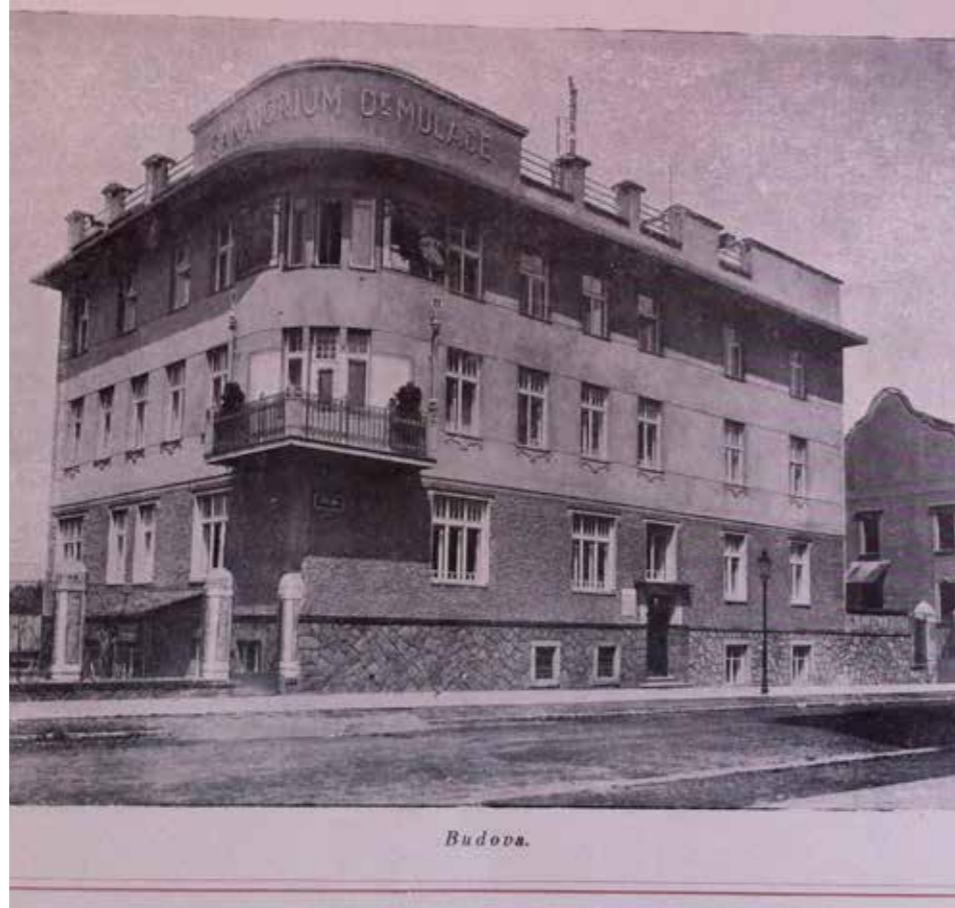
Po přístavbě operačních sálů, r. 1928
